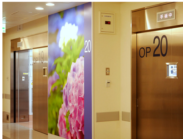
図1 手術室廊下の壁面パネル
